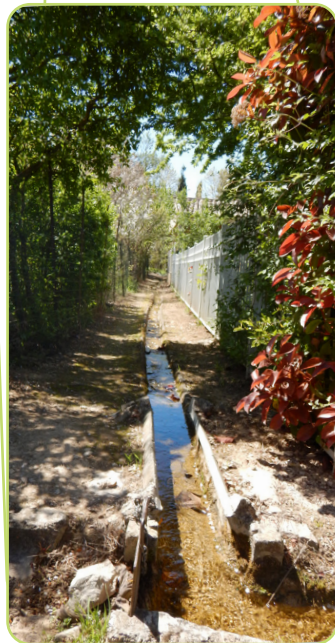
Canal des Clos La Roquebrussanne
