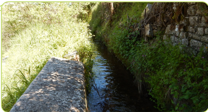
Canal communal de Carcès
