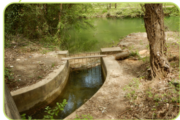
Canal communal de Carcès
