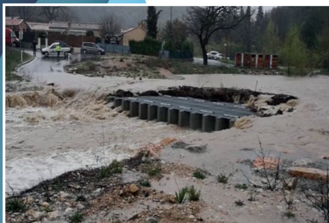
Gué aval lors de la crue d'avril 2018, accumulation d'embâcles en rive gauche et débordement généralisé
