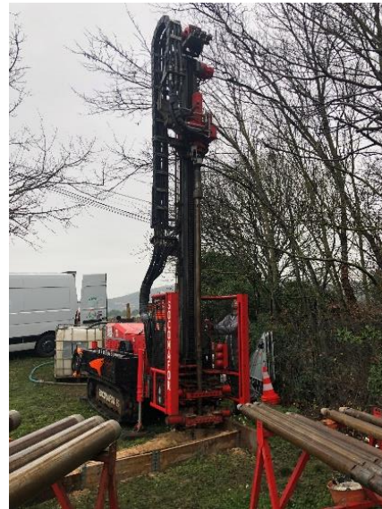
Installation des piézomètres sur les communes de Cabasse et Besse-sur-Issole
