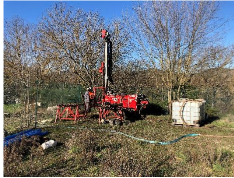
Installation du piézomètre sur la commune de Brignoles
