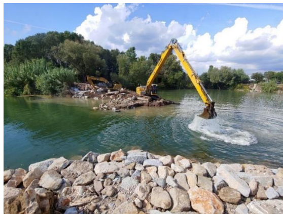
Suppression du seuil du moulin des Iscles en 2020.
