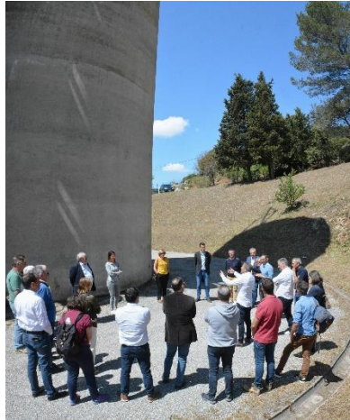
Commission Caramy-Issole (15/05/2023) : Restitution de l'étude sur l'amélioration de la connaissance des échanges aquifères du massif d'Agnis et visite du Brise-Charge de Signes
