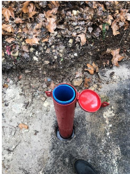
Installation des piézomètres sur les communes de Cabasse et Besse-sur-Issole
