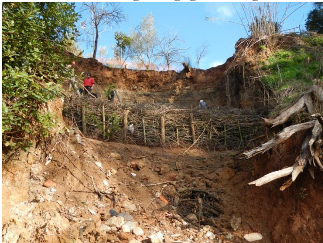
Nartuby rue des Horts : réalisation des deuxièmes et troisièmes peigne de stabilisation de talus
