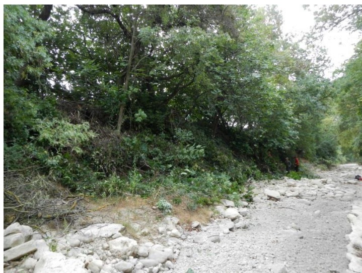
Draguignan aval pont de Lorgues : recépage de sujets déséquilibrés et élagage de la végétation en vue de maintenir une section d'écoulement optimale.
