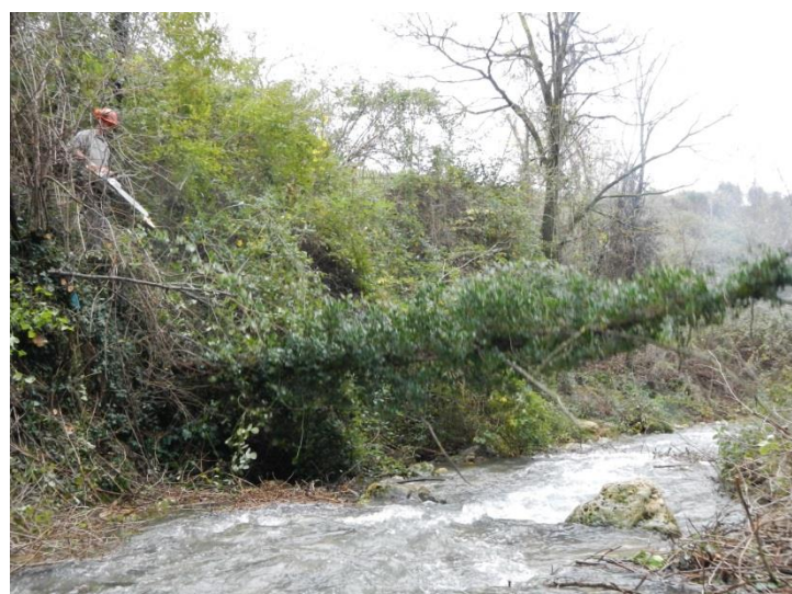
Nartuby à Montferrat amont D955 : avant intervention (à gauche) : embâcle et nombreux sujets morts sur pied ; (à droite et ci-dessous) : travaux de recépage en cours en vue de prévenir du risque d'obstruction de l'ouvrage busé.
