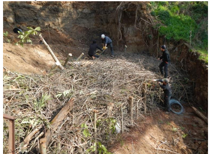
Nartuby rue des Horts : réalisation des deuxièmes et troisièmes peigne de stabilisation de talus
