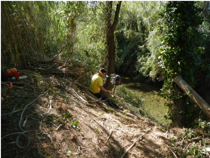
La Nartuby au Maralouche : le treuille est indispensable au retrait des grumes ; à droite ; débroussaillage en berge.
