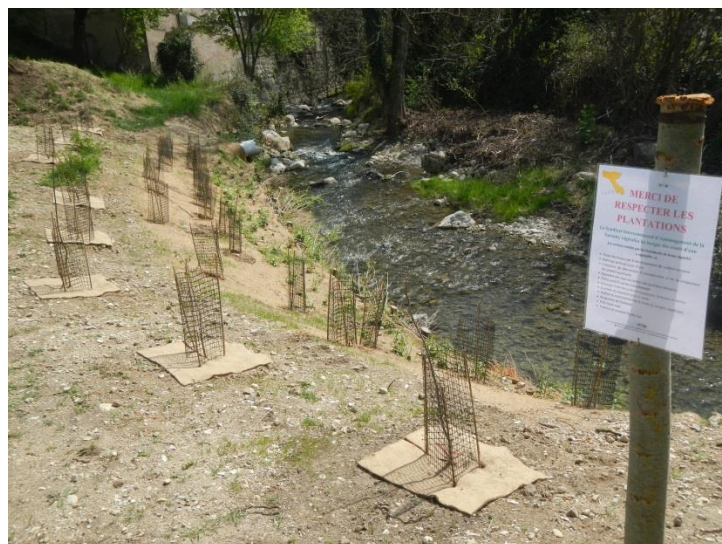
Nartuby à Montferrat centre : restauration de berge « génie végétal » et plantations.
