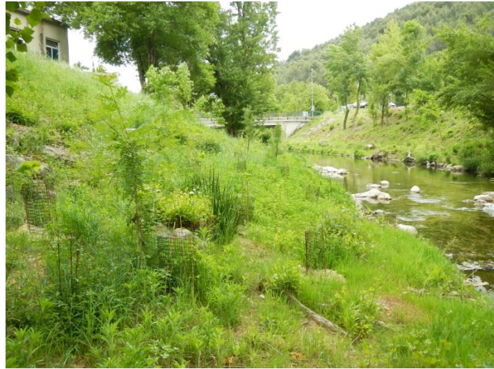
Draguignan amont saint Exupéry : reconstitution de ripisylve par plantations adaptées et diversifiées... strates arbustives préconisés en vue d'éviter le développement de points durs.
