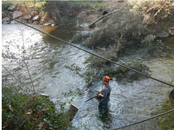
Trans en Pce amont D54 : traitement d'embâcle et recépage de nombreux sujets morts sur pied
