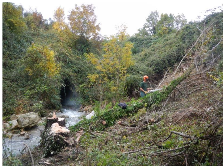
Nartuby à Montferrat amont D955 : avant intervention (à gauche) : embâcle et nombreux sujets morts sur pied ; (à droite et ci-dessous) : travaux de recépage en cours en vue de prévenir du risque d'obstruction de l'ouvrage busé.
