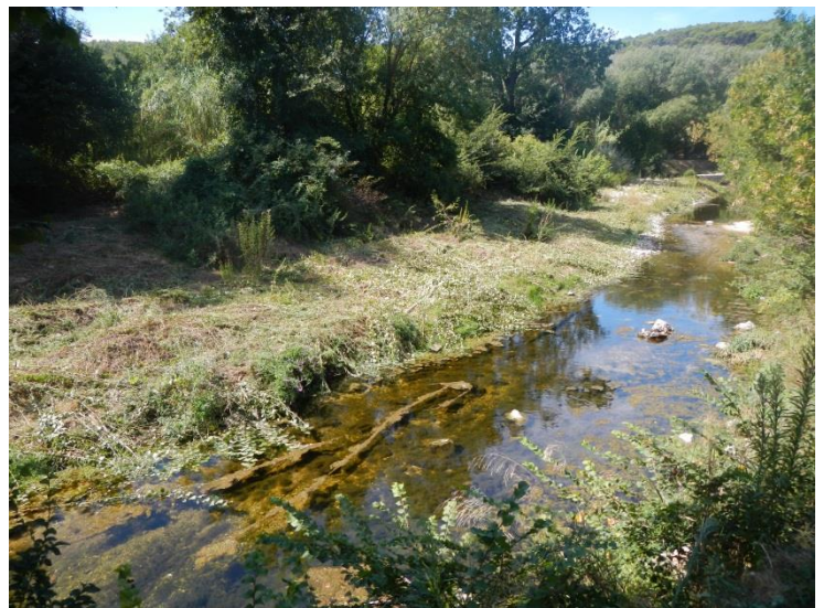
Draguignan secteur Salamandrier (à gauche) et Incapis aval : débroussaillage en berge (mise en valeur du milieu et maintien d'une section d'écoulement optimale) et d'atterrissement en vue de limiter les dépôts sédimentaires.
