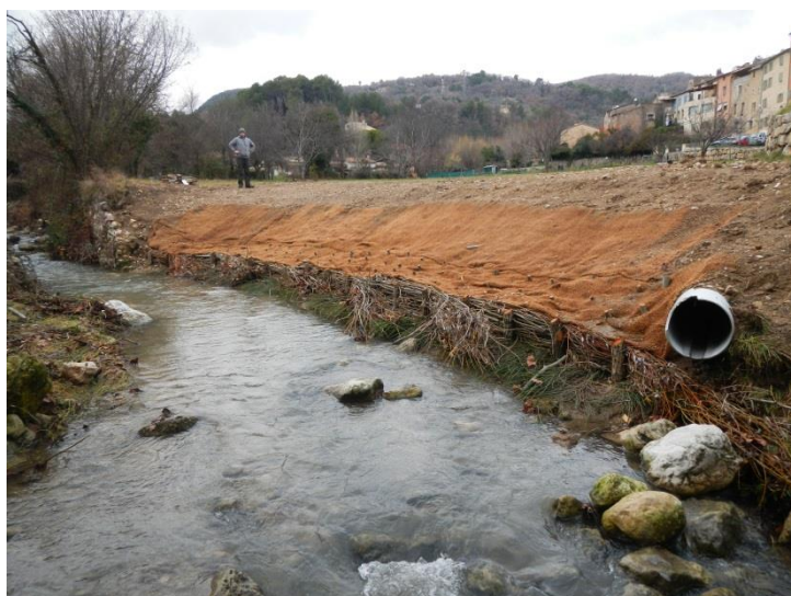
Nartuby à Montferrat centre : restauration de berge « génie végétal » et plantations.
