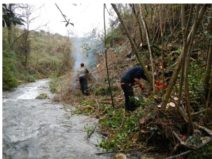
Nartuby à Montferrat amont D955 : avant intervention (à gauche) : embâcle et nombreux sujets morts sur pied ; (à droite et ci-dessous) : travaux de recépage en cours en vue de prévenir du risque d'obstruction de l'ouvrage busé.
