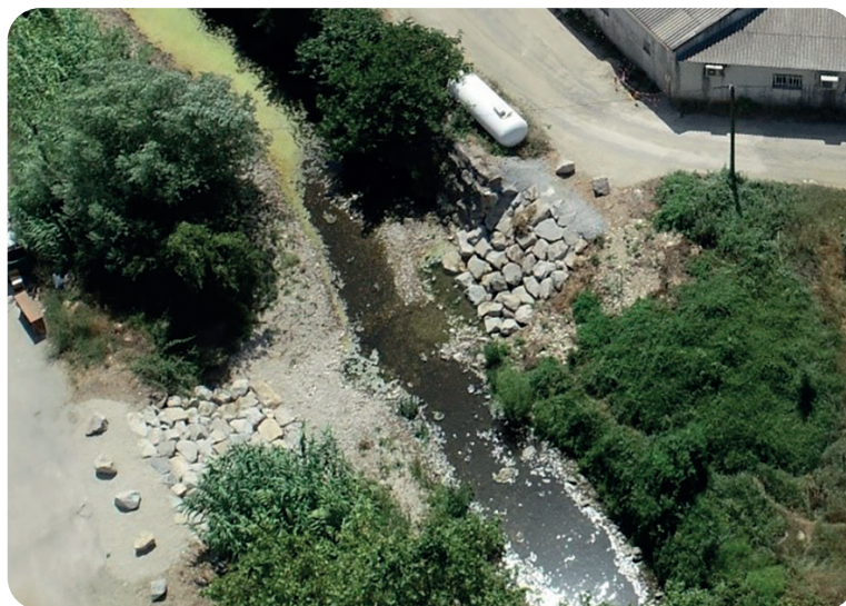
Travaux de préfiguration : démolition d'une passerelle privée à Draguignan en juin 2019
