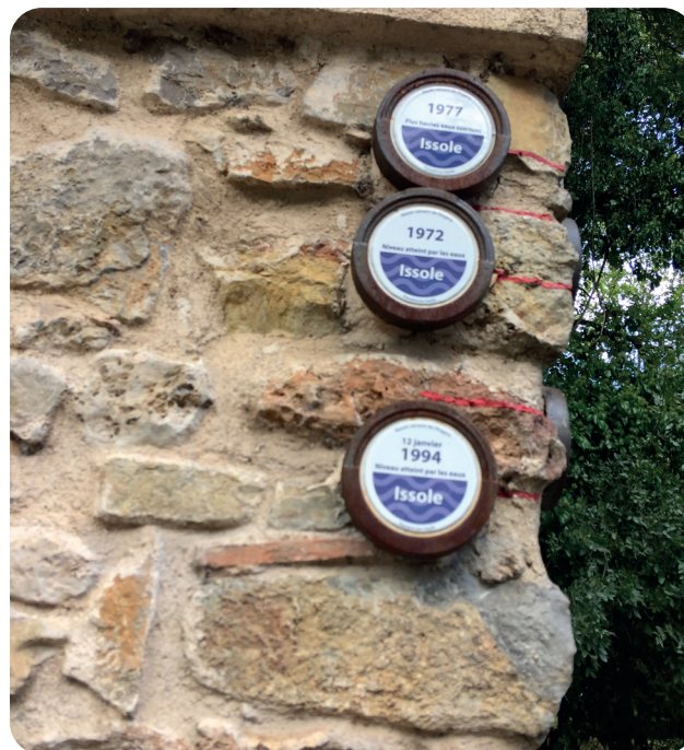
Repères de crue du lavoir à Flassans-sur-Issole
