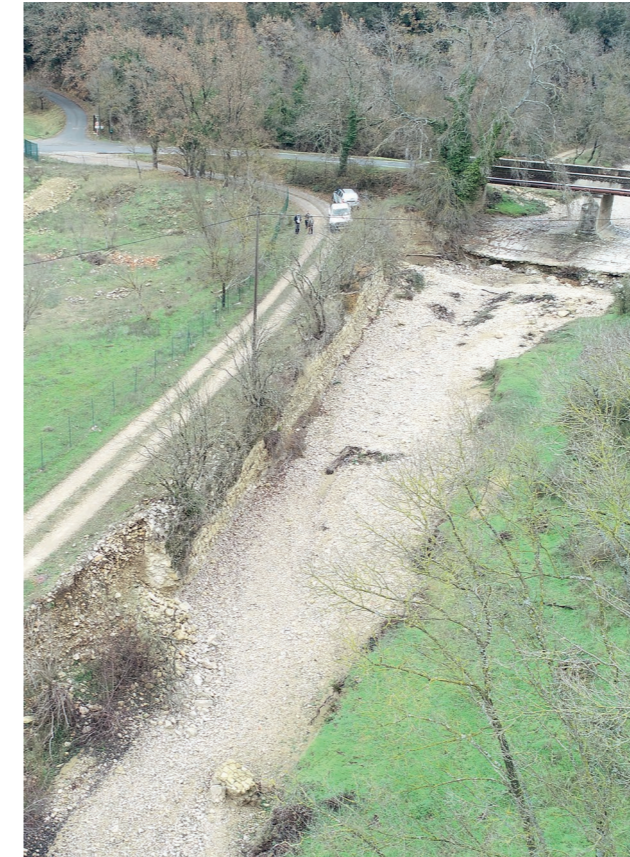
Pont de la RD51 - Châteaudouble
