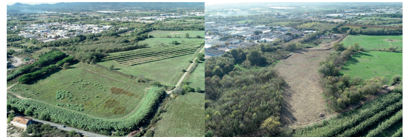
Travaux forestiers préparatoires réalisés en octobre 2020.
