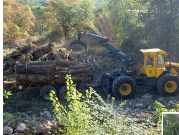
Intervention de l'entreprise SNEP DOS SANTOS sur la Nartuby
