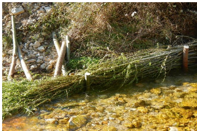
Pose d'épis déflecteur vivants et de boutures sur le secteur de la Tuilière
