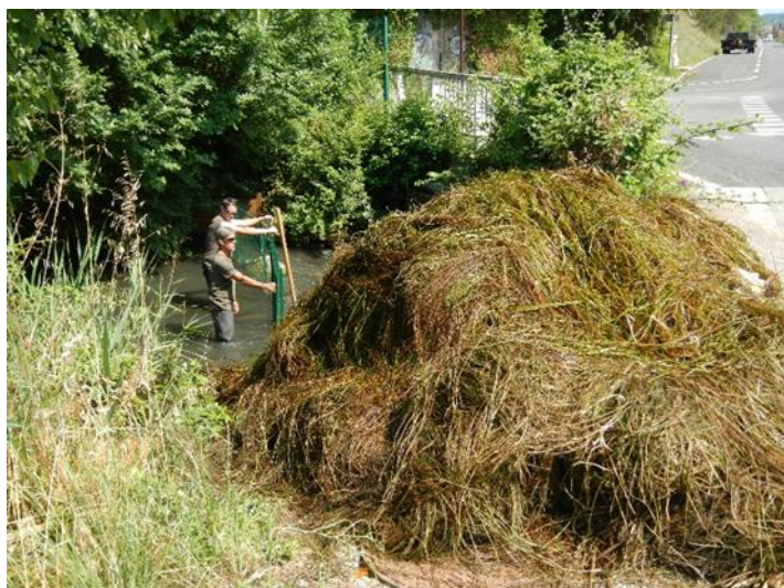
Faucardement : les produits de coupe sont interceptés et évacués
