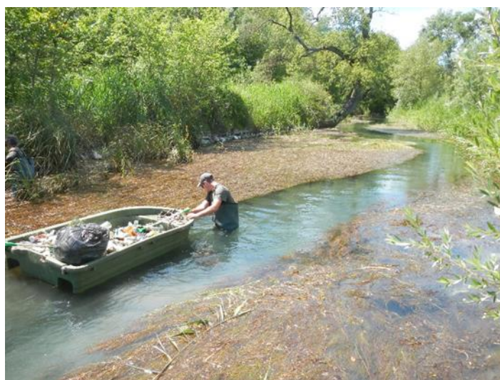
Faucardement : les produits de coupe sont interceptés et évacués
