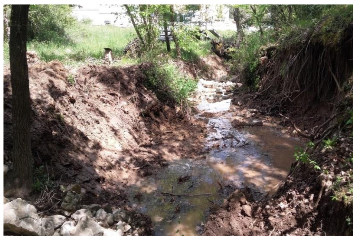
Le Claret : glissement d'une souche obstruant le cours du Claret – photos avant et après intervention
