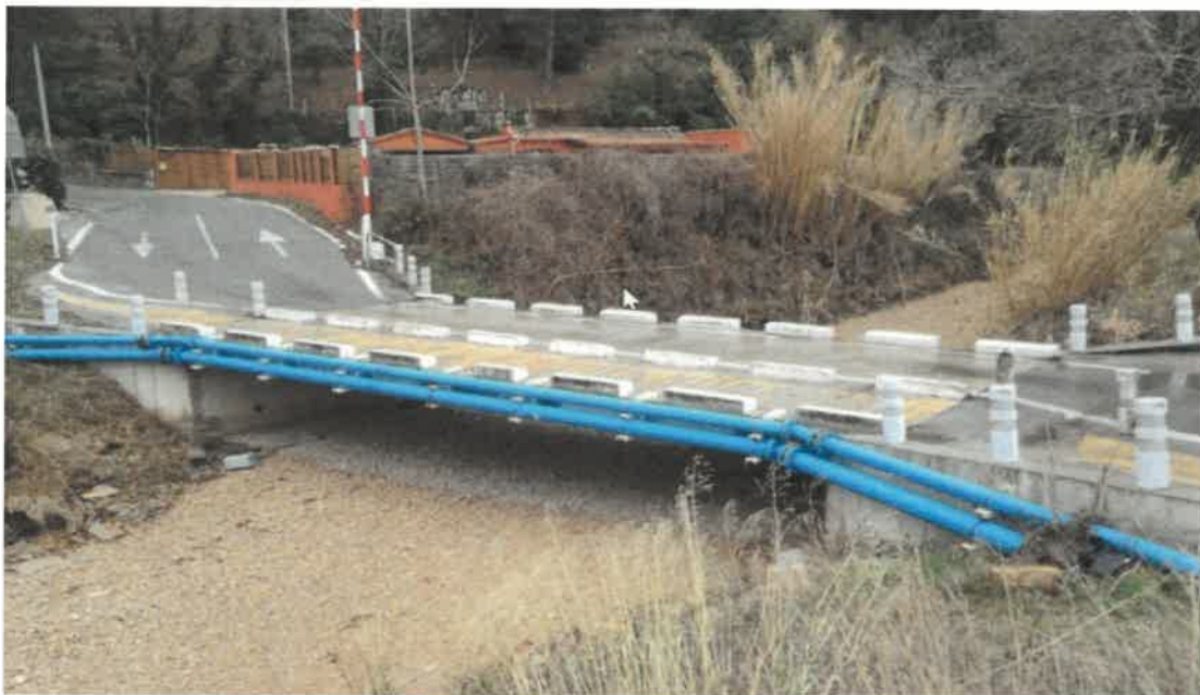
Figure 1 : Pont des Incapis (ouvrage actuel)
